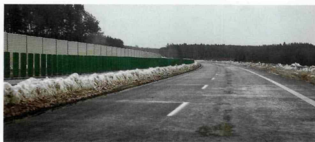
Fot. 3. Zimowe utrzymanie, czyli usunięcie warstwy śniegu z powierzchni jezdni wykonane „prawie” zgodnie z wytycznymi, jednak wały odgarniętego śniegu i zbrzydlonego lodu są dużo wyższe niż w przypadku z fot. 2; na jezdni są widoczne języki śnieżne; prędkość pojazdu, z którego wykonano zdjęcie, wynosiła 100 km/h
