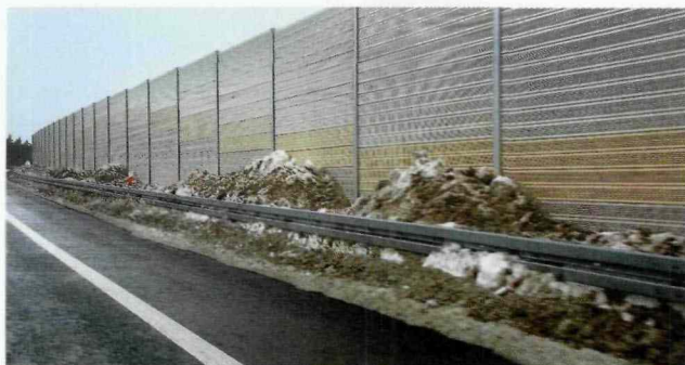
Fot. 5. Negatywny przykład zimowego utrzymania (formowania wałów śniegu i zbrzydlonego lodu), wykonanego niezgodnie z wytycznymi (9)
