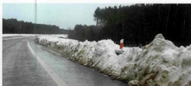
Fot. 4. Zimowe utrzymanie wykonane niezgodnie z wytycznymi (9)
