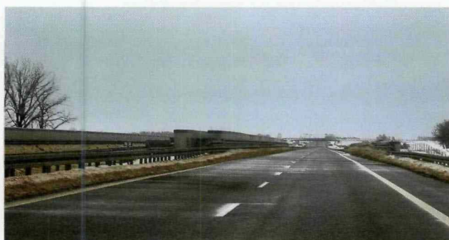
Fot. 6. Przykład nieprawidłowego składowania wałów śniegu – stan na tydzień po dużych opadach śniegu i przeprowadzonej akcji odśnieżania ekspresowej drogi dwujezdniowej
