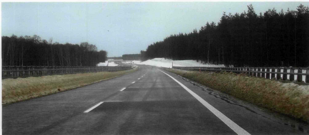
Fot. 7. Przykład nieprawidłowego składowania wałów śniegu – stan po 10 dniach od zamieci i przeprowadzonej akcji odśnieżania ekspresowej drogi dwujezdniowej; w trakcie odwilży i dodatniej temperatury powietrza w ciągu dnia rozpoczyna się proces tajania wałów śniegu na powierzchni obiektu, a nocą – ponownego zamarzania wody ze stopionych wałów
